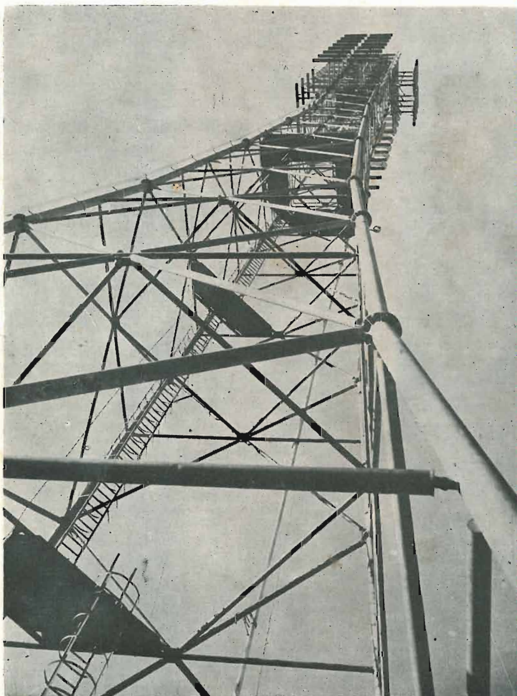
La torre che sostiene l'antenna del Centro Trasmettente televisivo di Monte Faito
